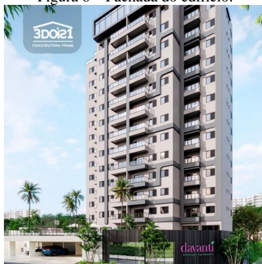
Figura 6 – Fachada do edifício.
