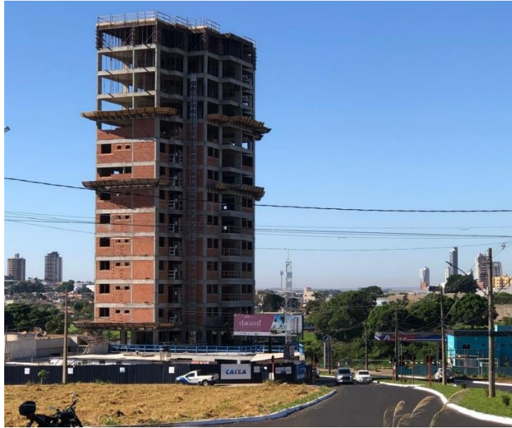
Figura 7 – Desenvolvimento da obra do edifício.
